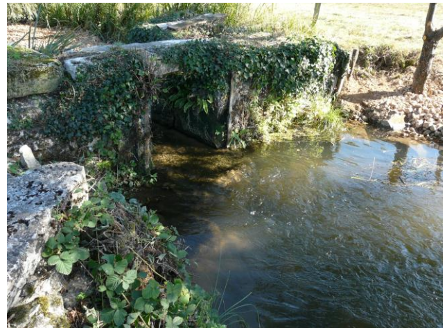
Photo du seuil après travaux
