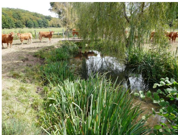
Photo de l'amont du seuil avant travaux
