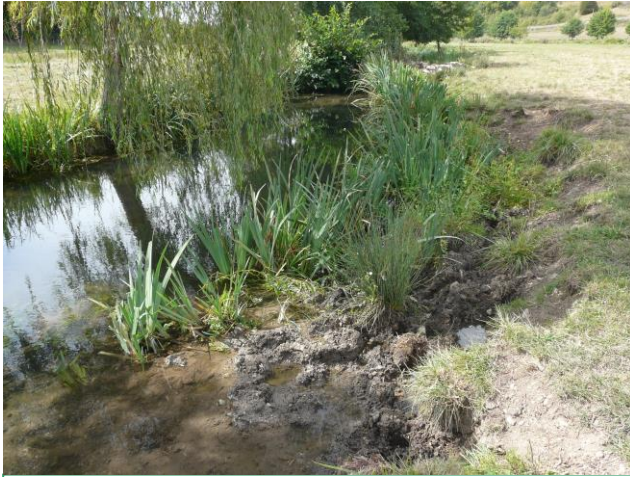
Photo de l'amont du seuil avant travaux
