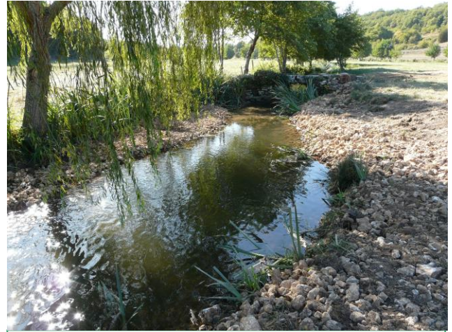
Photo de l'amont du seuil après travaux
