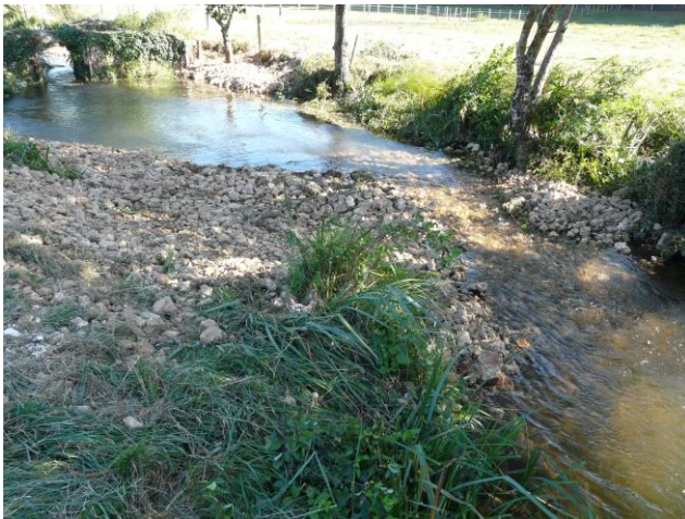
Photo de l'aval du seuil après travaux
