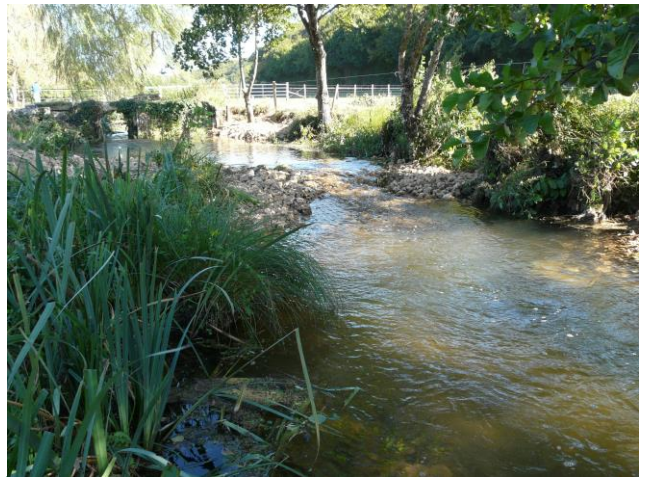
Photo de l'aval du seuil après travaux
