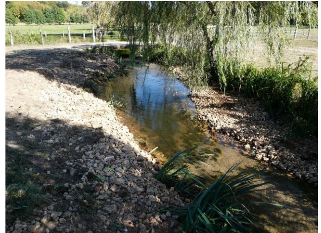
Photo de l'amont du seuil après travaux
