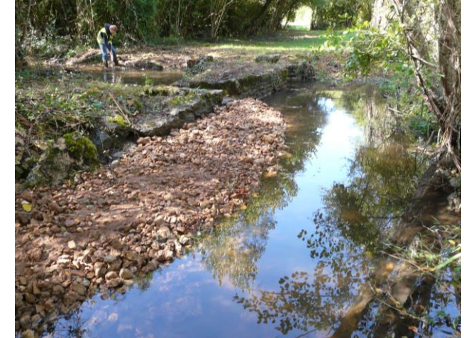
Photo de l'amont du seuil après travaux
