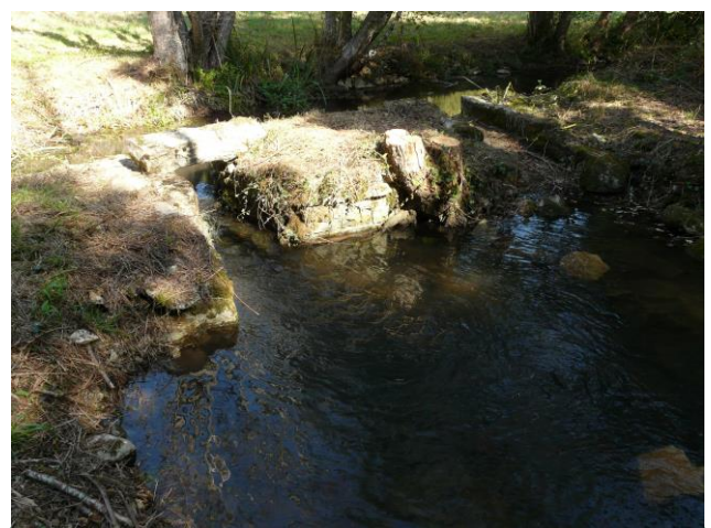
Photo du seuil après travaux
