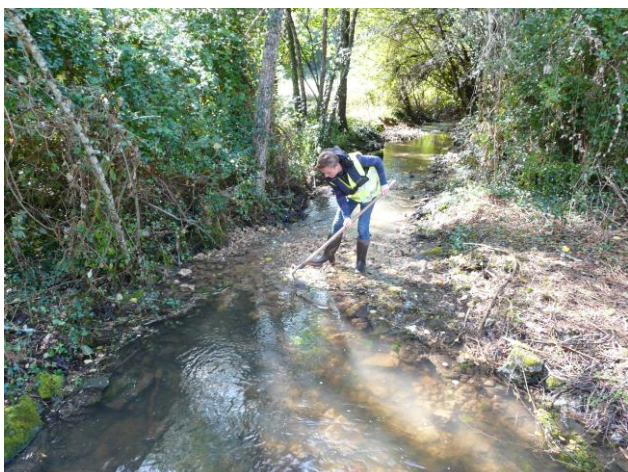
Photo de l'aval du seuil pendant les travaux
