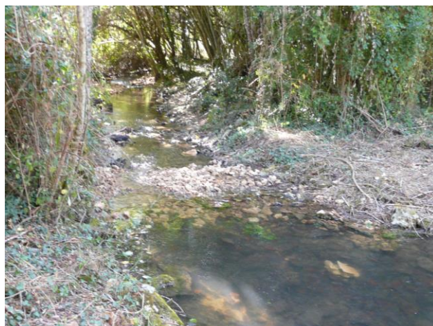
Photo de l'aval du seuil après travaux
