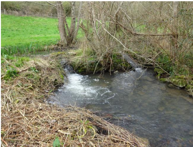
Photo du seuil avant travaux
