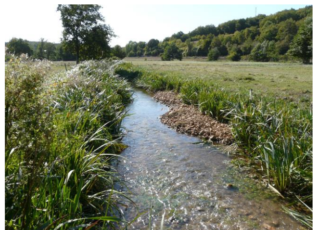
Photo après travaux (vue aval du radier)
