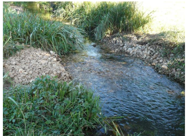
Photo après travaux (création d'un radier)
