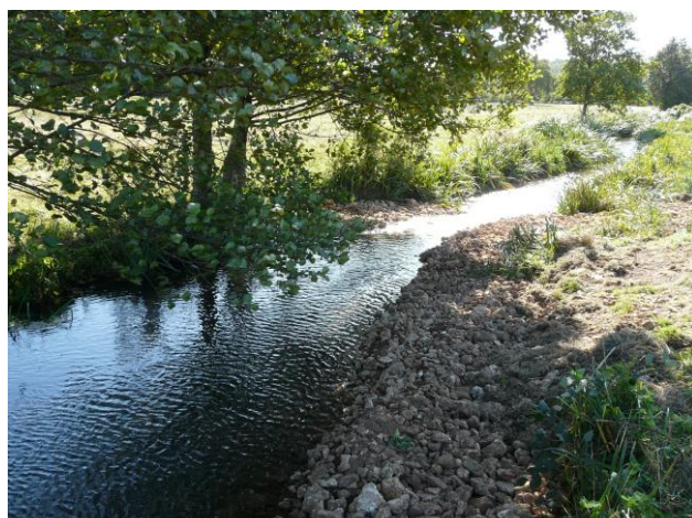
Photo après travaux (vue amont du radier)
