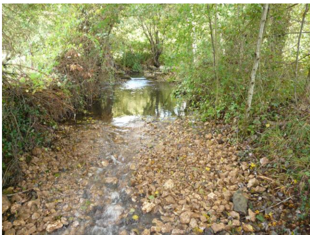
Photo de l'aval du seuil pendant les travaux
