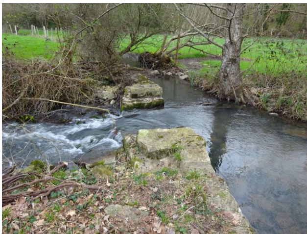
Photo du seuil avant travaux
