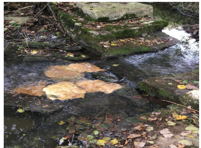
Photo du seuil après travaux
