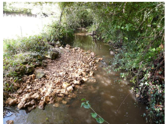
Photo de l'aval du seuil après travaux
