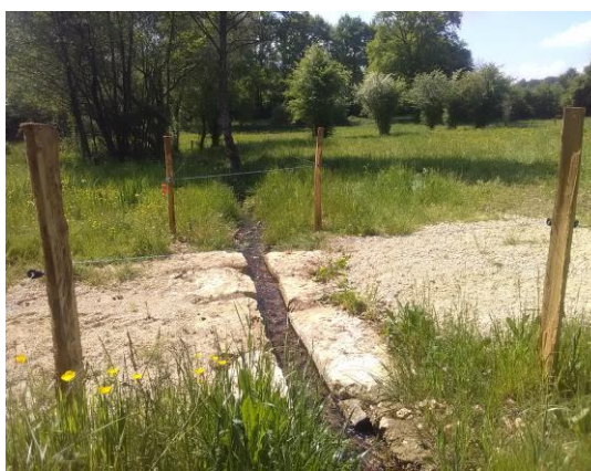
après travaux (gués/abreuvoirs)
