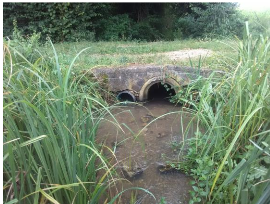
Avant travaux continuité contrainte
