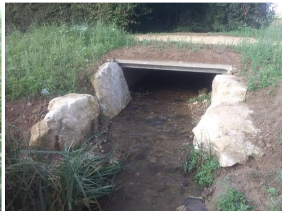
après travaux continuité respectée
