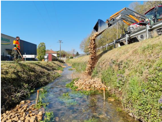
Mise en place de banquettes minérales
