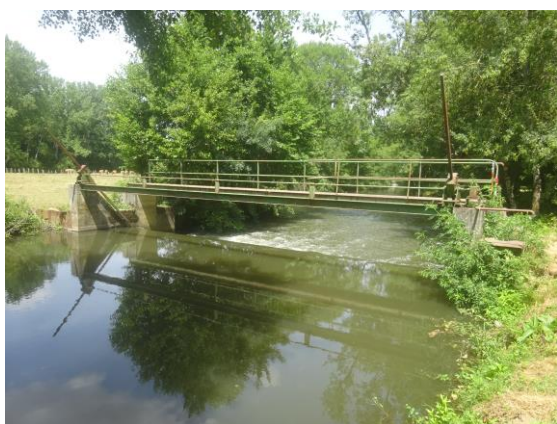
Continuité écologique avant travaux
