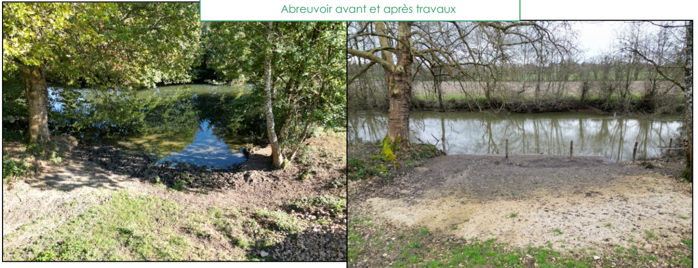
Abreuvoir avant et après travaux
