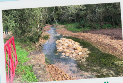
Renaturation de cours d'eau
