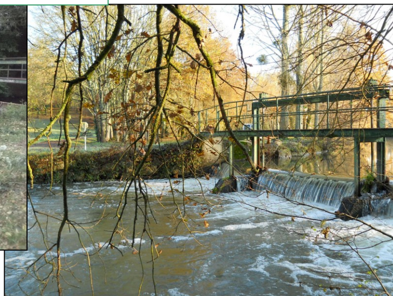
Site et ouvrages avant travaux
